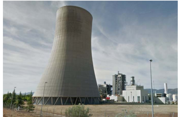
Figura 2. Vista de la Torre de Refrigeración a demoler
