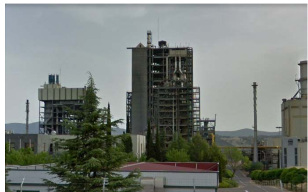
Figura 3. Vista de la Torre de Gasificación a demoler
