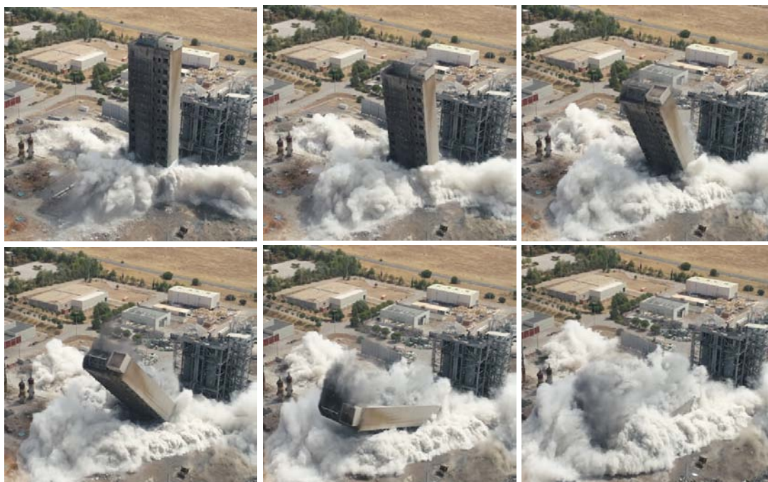
Figura 17. Fotografías del proceso de caída de la Torre de Gasificación.
