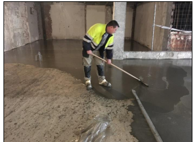
Figura 17. Extendido del mortero
