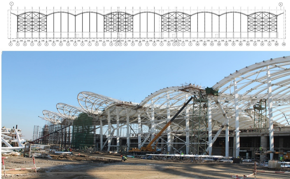
Figura 17. Aspecto general de la fachada principal durante su construcción. En la zona superior de la imagen, esquema resistente de la misma.
