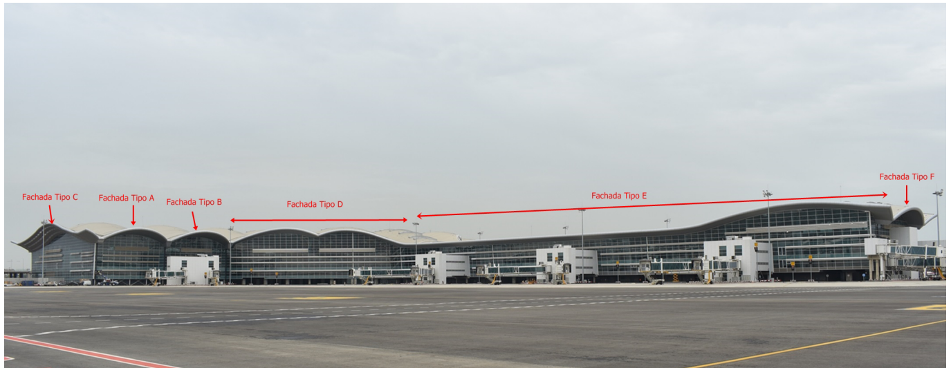
Figura 30. Panorámica general del edificio y aspecto final de las fachadas tipo B, C, D, E y F.
