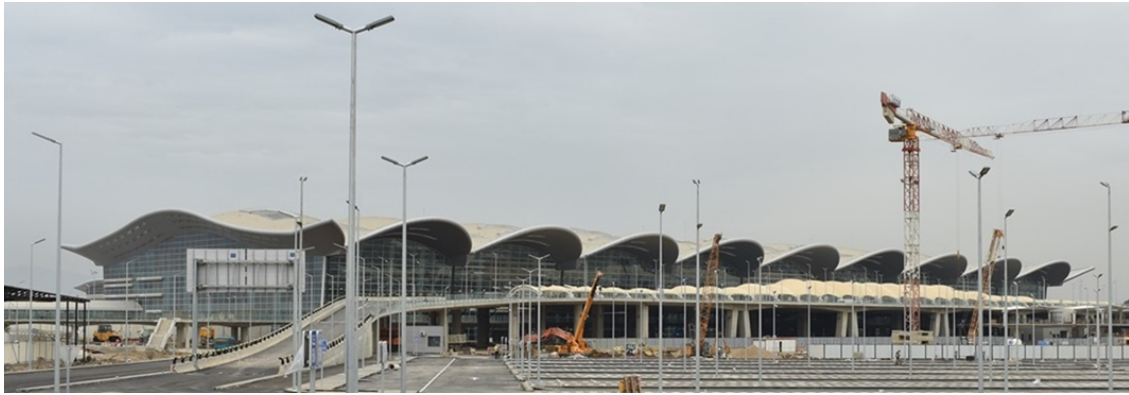
Figura 7. Imagen general de la cubierta del procesador, con los viaductos de acceso en primer plano.
