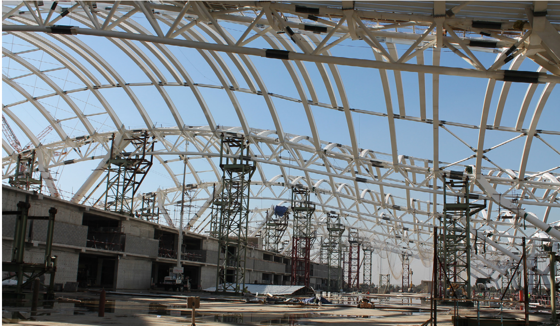
Figura 8. Cubierta del procesador, durante la fase de montaje, donde puede apreciarse el apoyo central.
