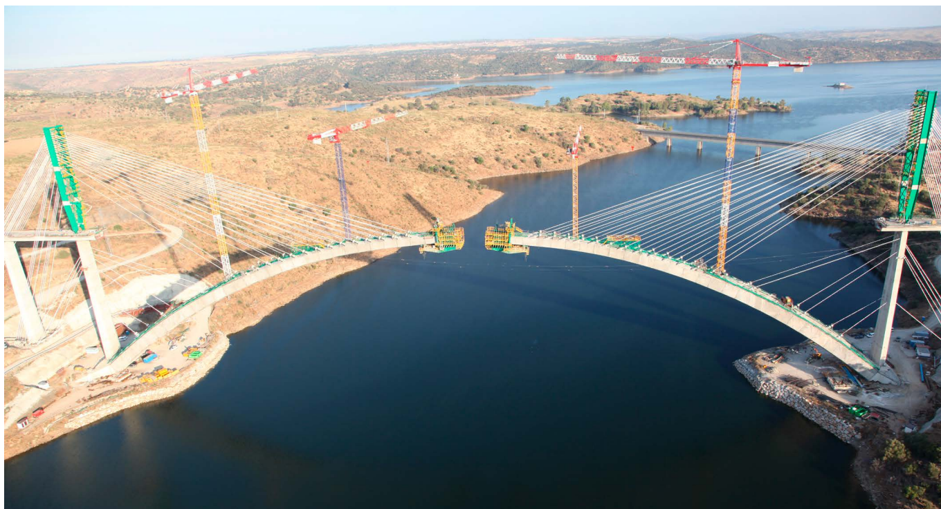
Figura 1. Vista general del arco en construcción.
