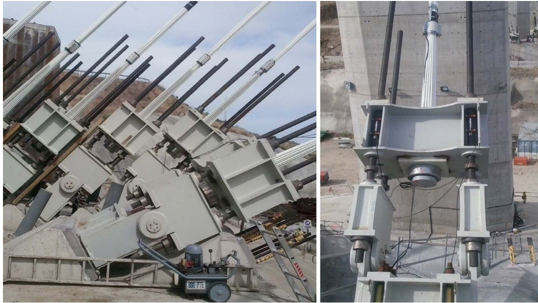
Figura 26. Bastidores. Anclaje al terreno y al arco.
