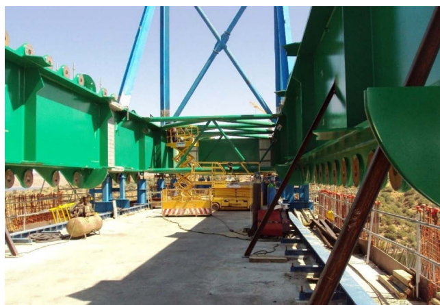
Figura 25. Torre apoyada sobre castilletes.
