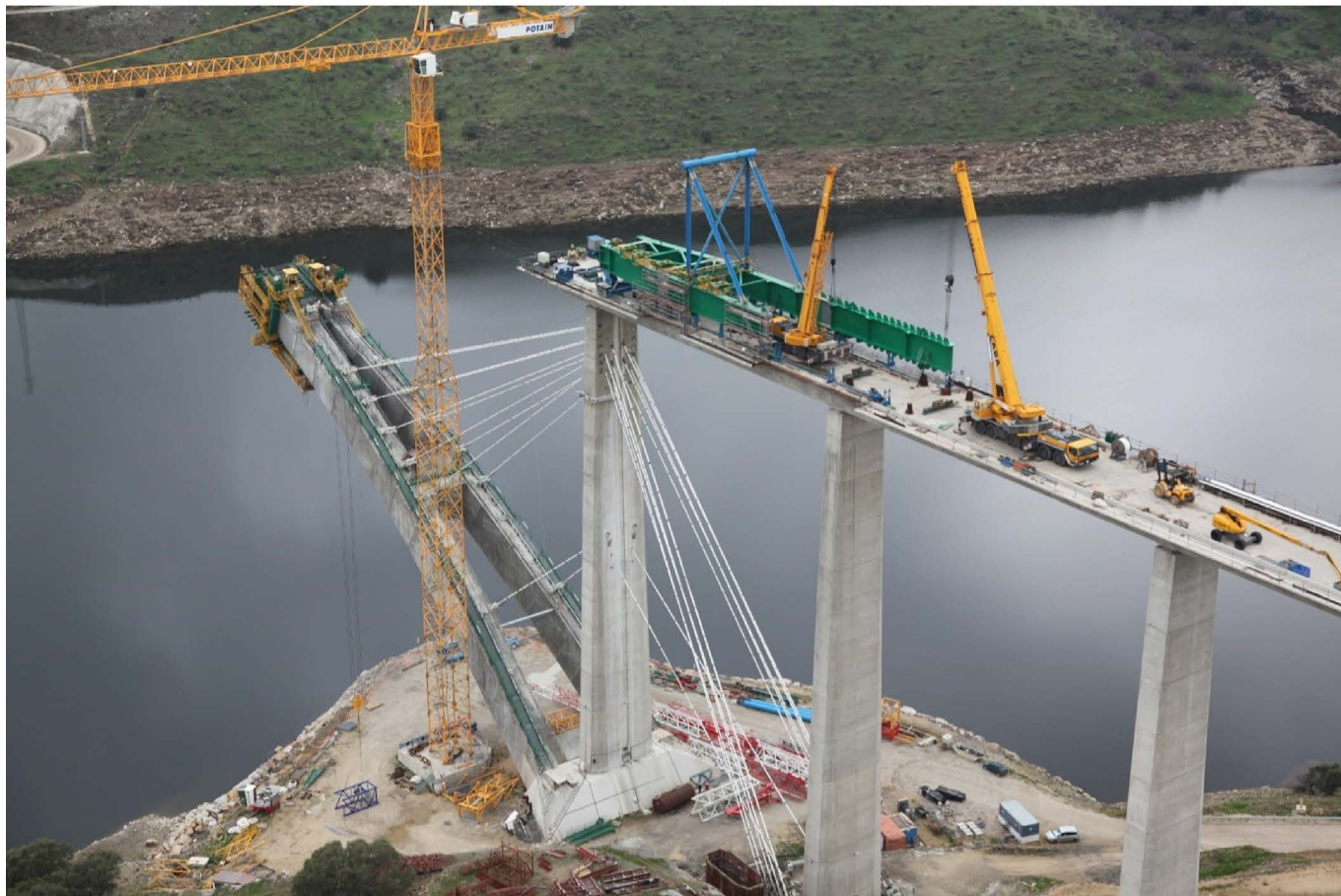
Figura 24. Montaje de torre sobre tablero.
