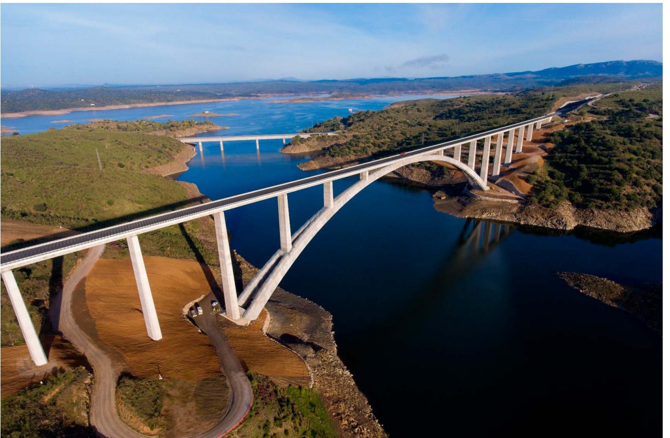
Figura 12. Vistas aéreas del viaducto de Almonte (Fuente: FCC).
