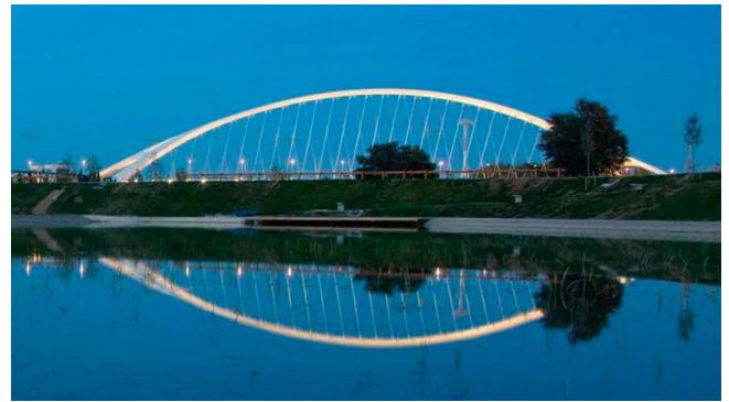
Figura 3. La esbeltez como aplicación rigurosa de la antifunicularidad. Puente del Tercer Milenio, Zaragoza.
