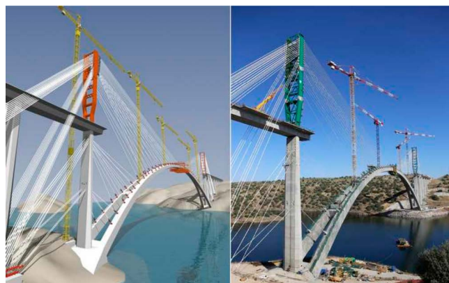
Figura 9. Comparativa entre el procedimiento constructivo desarrollado durante el proyecto, y la imagen real durante la ejecución de las obras.
