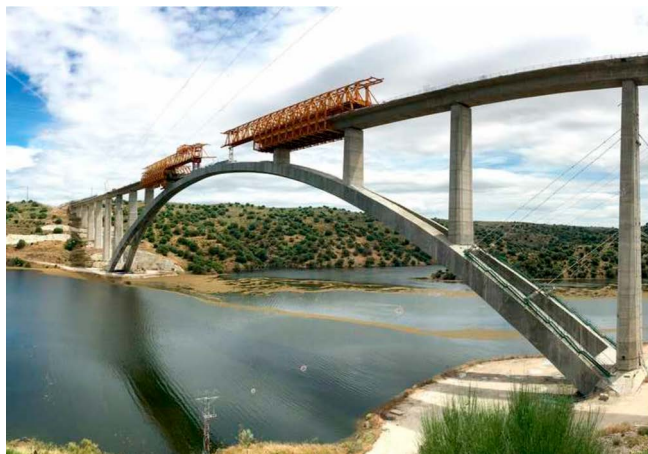
Figura 11. Ejecución de los últimos vanos del tablero.
