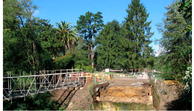
Figura 21. Estado de demolición parcial del puente de Butrón original.
