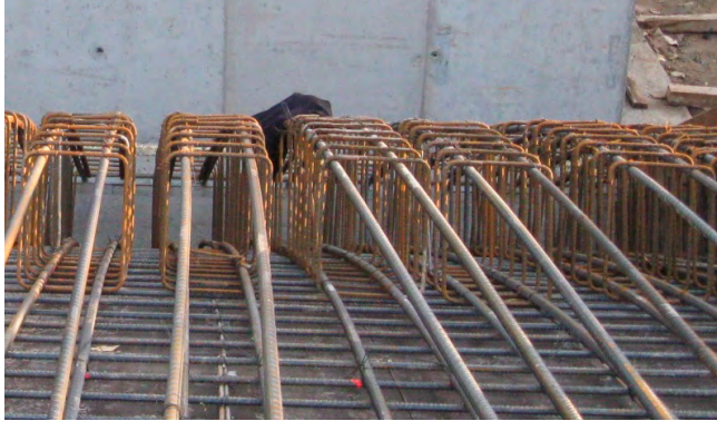
Figura 28. Detalle de ferrallado en arranque de arco.
