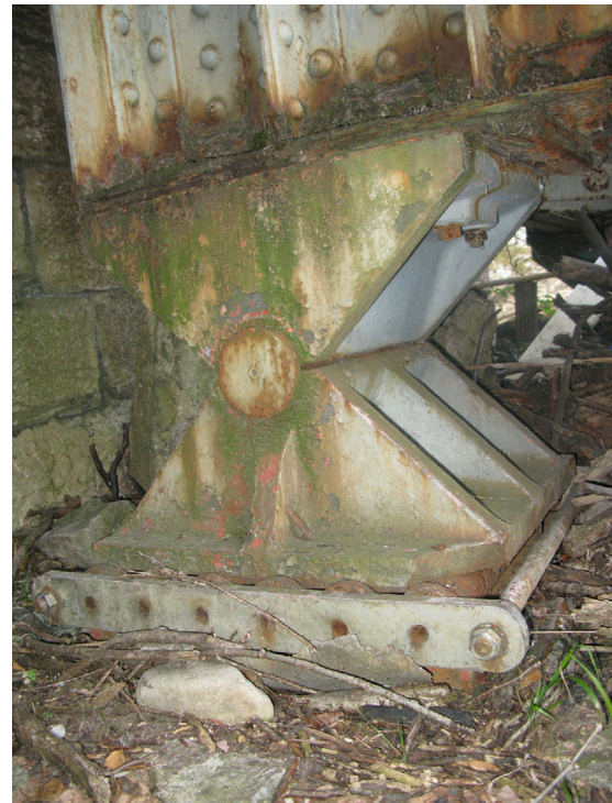
Figura 2. Apoyo deslizante del mismo puente.
