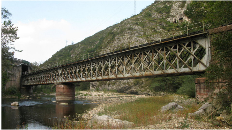
Figura 8. Vista general del puente desde aguas arriba.
