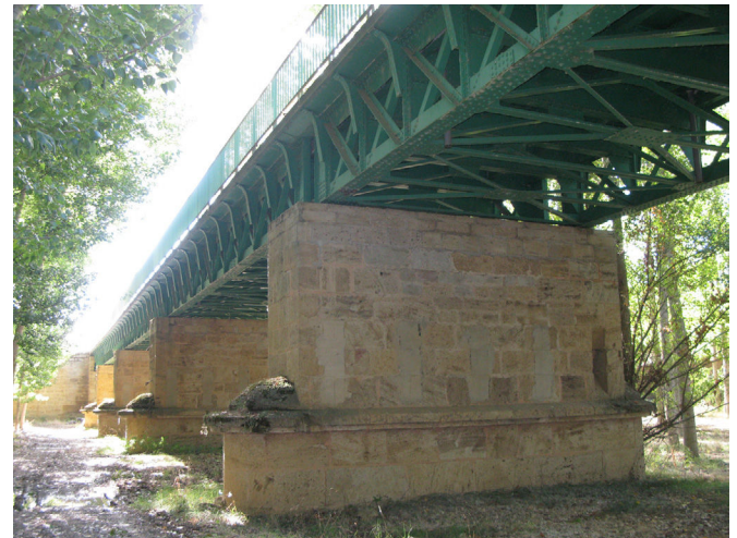
Figura 5. Vista del tablero metálico.
