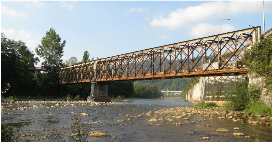
Figura 6. Vista general del puente.
