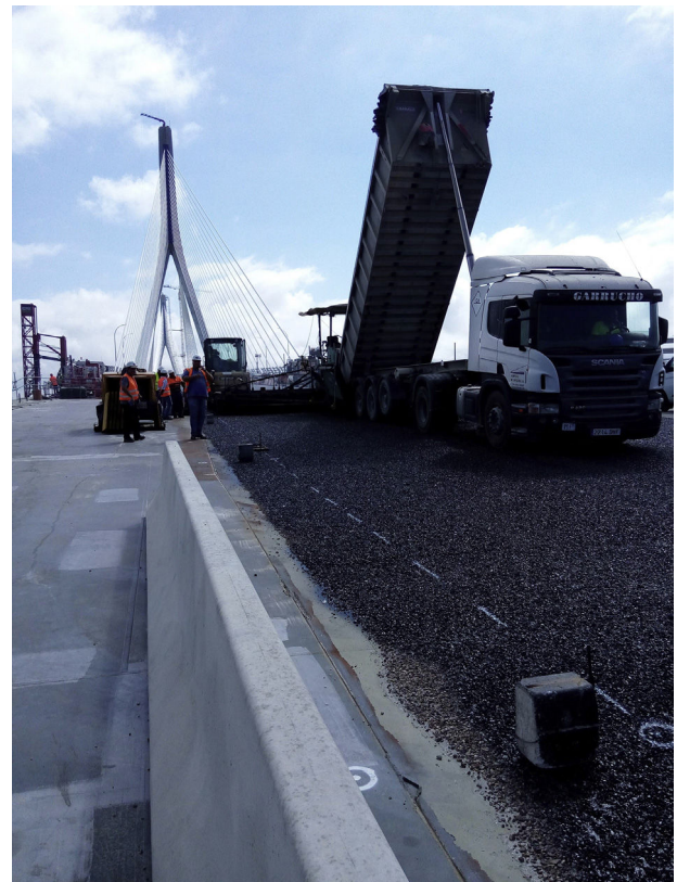
Figura 6. Extendido del firme del tramo desmontable.
