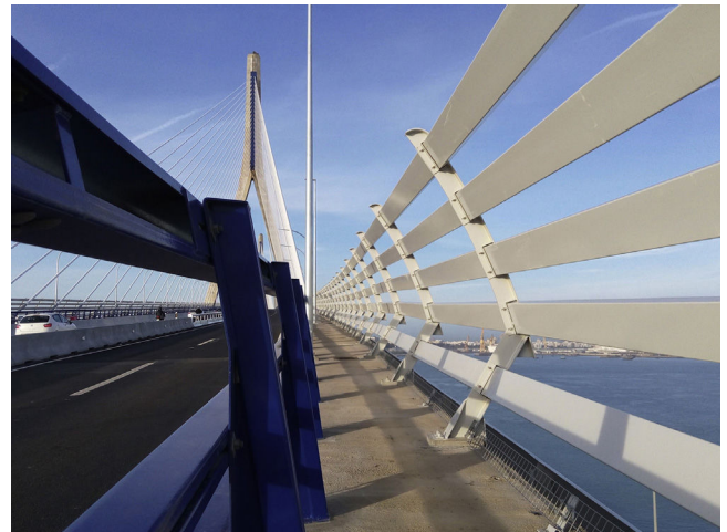
Figura 8. Pantallas antiviento en el tramo atirantado.
