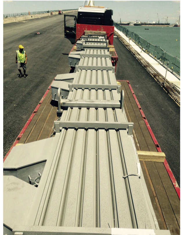
Figura 1. Junta de dilatación. Estribo 1.
