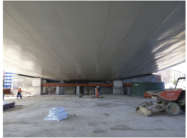
Figura 2. Sistema de drenaje del tablero.
