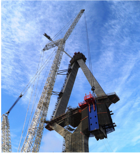
Figura 18. Izado de cajones con grúa sobre cadenas.
