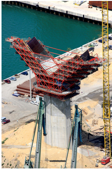
Figura 10. Fustes inclinados inferiores cimbrados.
