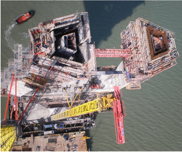
Figura 14. Encofrado autotrepante de fustes inclinados. Puntales entre fustes.
