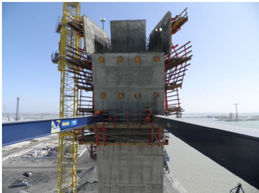
Figura 17. Puntales entre fustes inclinados superiores.
