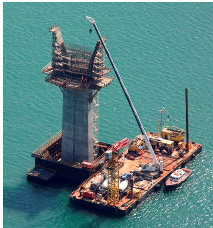
Figura 7. Construcción de pilas monofuste en mar.
