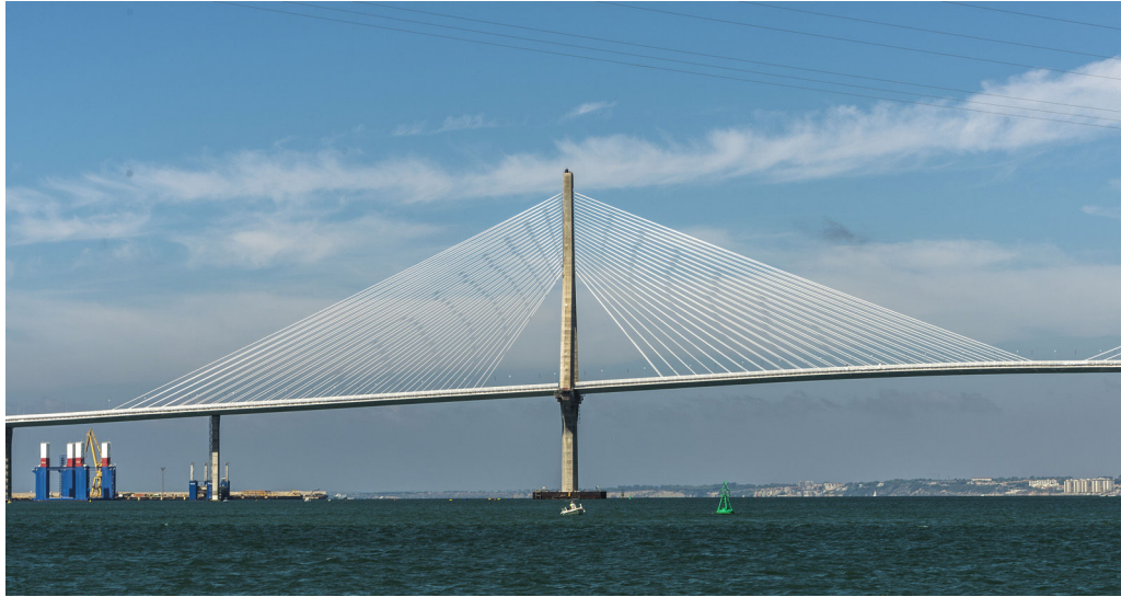
Figura 31. Vista lateral de la torre.
