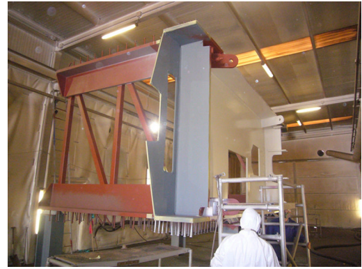
Figura 29. Base de apoyo del armario metálico en taller.
