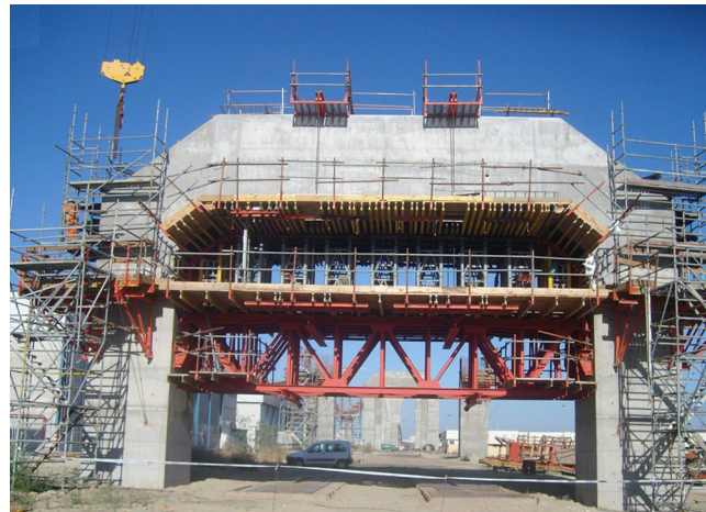
Figura 8. Construcción de pilas pórtico en tierra.
