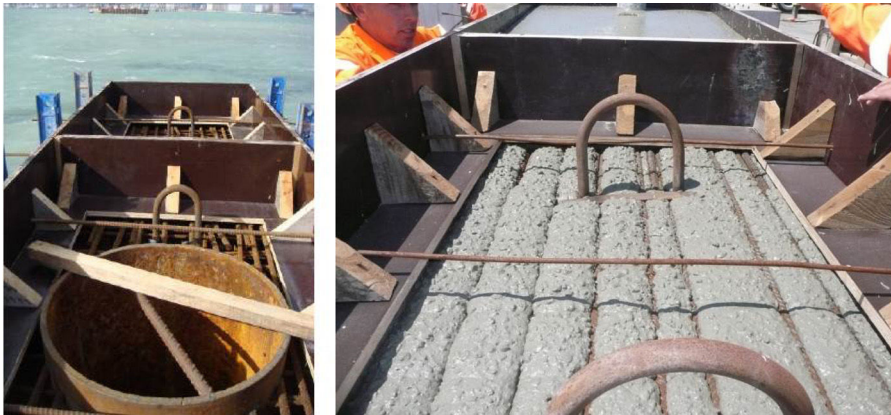
Figura 8. Llenado de molde en superficie.
